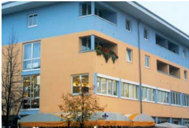
Abb. 2: Im Februar 2000 wurde das neue Domizil des Labors in Pocking bezogen.
